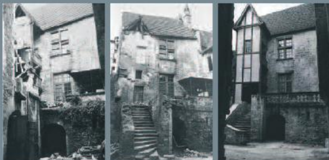
Sarlat > La Maison Bizac avant, pendant et après travaux (1969-70). Sarlat est la ville d'origine de la Loi Malraux. A la fin du programme mené en grande partie par l'architecte Marc Robert, elle deviendra un modèle pour les restaurations des autres centres historiques français.
